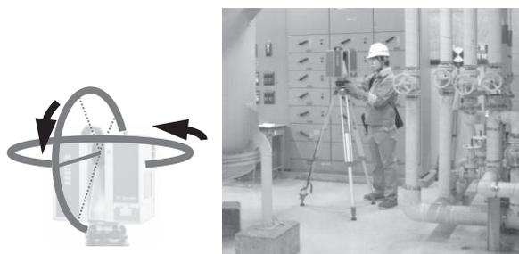
全天球レーザースキャンが、高解像度モードの場合で、約3分で完了
