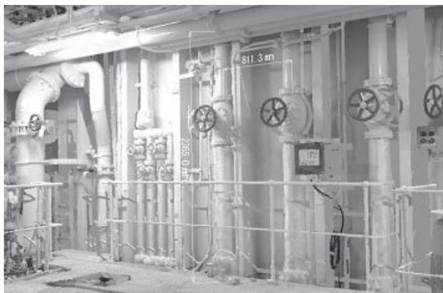
点群モデル内の2点をマウスクリックすると、引き出し線、寸法線、計測数値が表示される
